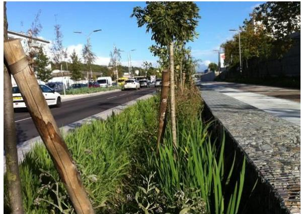
Figure 27 : Exemples de réalisations de voirie avec noues plantées
